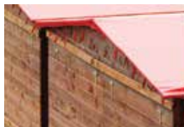
Bâche d'étanchéité de toit
